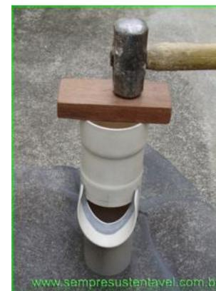
Faça isso até que a parte de baixo do corte de 45° do tubo inferior comece a aparecer na parte inferior da boca do tubo superior, ficando só um pouquinho acima.
