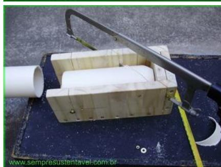
Como resultado desses cortes você terá: um pedaço de tubo de 19cm com uma ponta cortada em 45° e dois pedaços pequenos que servirão para o próximo passo, que é a montagem da peça superior desse filtro.
