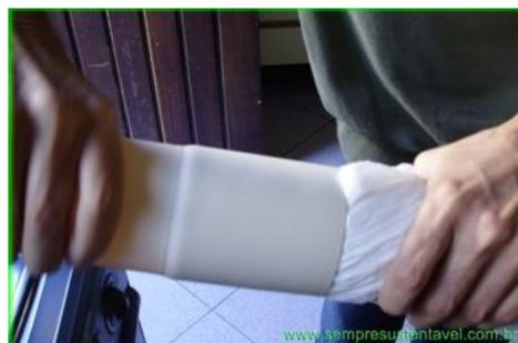
Depois retire o plástico e confira o encaixe. Essa bolsa deve encaixar sobre o outro tubo levemente justa, sem precisar forçar.
