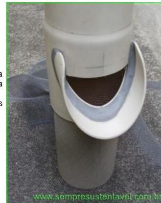
Depois coloque sobre tudo, um pedaço de madeira, e com um martelo, bata devagar sobre a madeira. Assim vai forçar o encaixe dos dois tubos e ao mesmo tempo, vai esticando a tela.
