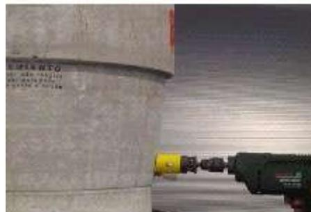
3. Fazer mais dois furos de 25 mm de diâmetro na lateral esquerda e outro na parede oposta. Procure fazer esses furos o mais alto possível, para obter um maior volume de água armazenada no reservatório. Aconselha-se que o centro dos furos mantenha uma distância de aproximadamente 8 cm da margem superior da caixa.
