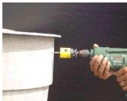
A caixa ficará com um total de cinco furos. Os dois superiores são entrada de água da rua e a saída do ladrão. Os três furos inferiores são, entrada e saída para os coletores e a saída para o chuveiro. Não foi mencionado o furo de consumo de água fria, pois esta é uma caixa exclusiva para água quente.
