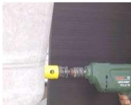
2. Fazer um terceiro furo com diâmetro de 25 mm numa parede perpendicular a dos furos anteriores. O centro desse furo pode estar uma altura máxima da metade da altura total da caixa. Instalar nesse furo o adaptador soldável com flanges de 25 mm pelo qual passará a água da caixa para o chuveiro.
